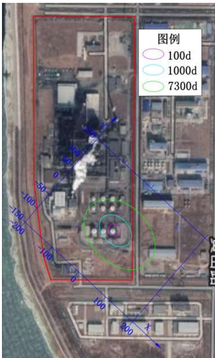
图 7.4-1 原料油罐区风险状况泄漏后葱超标范围预测图
