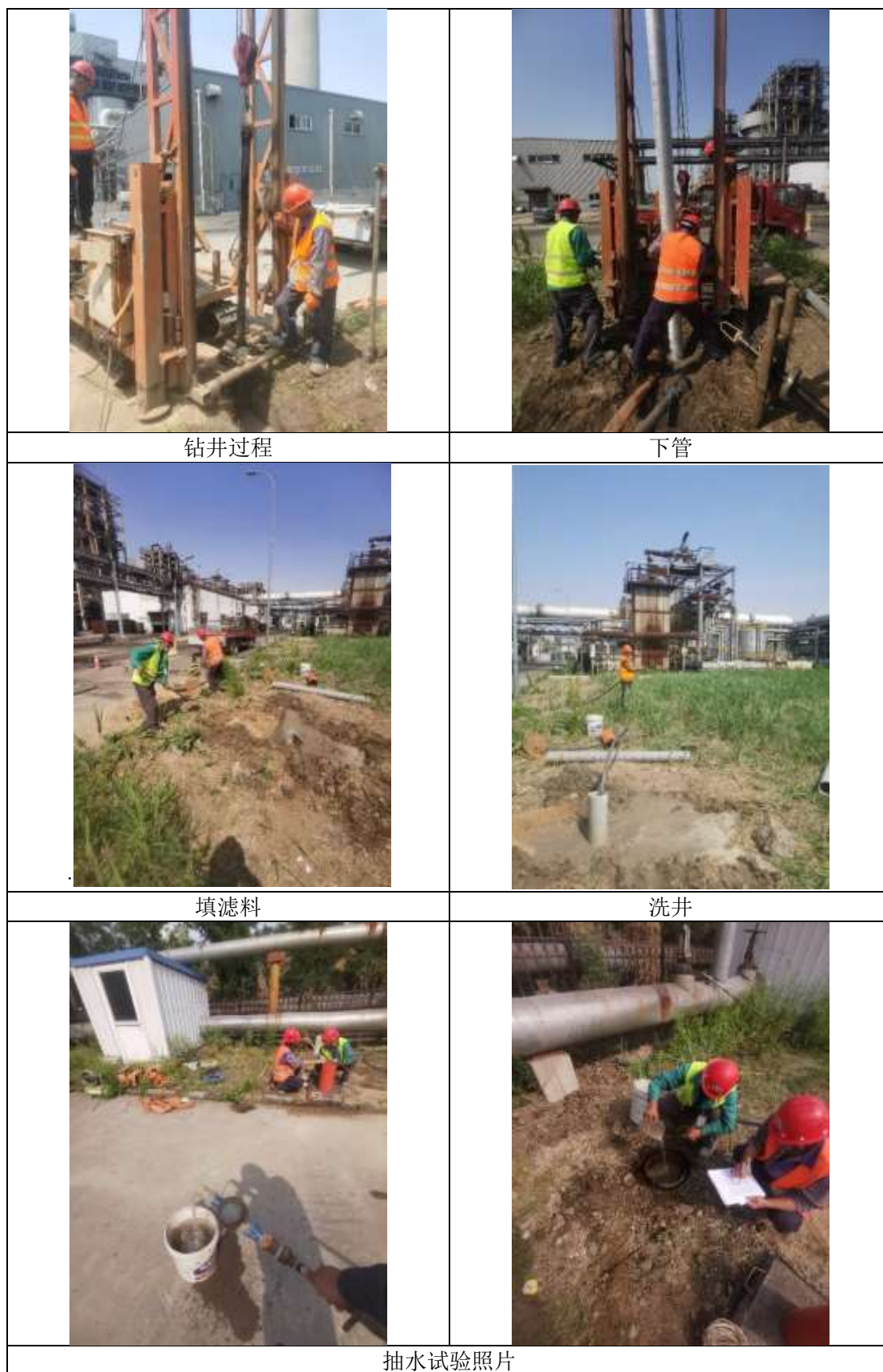
照片 4.2-1 水文地质钻探施工、抽水试验
