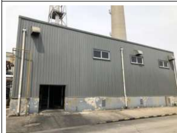
一期生产废水处理设施
